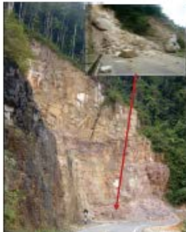
Fig. 3: Vista del talud inestable.
