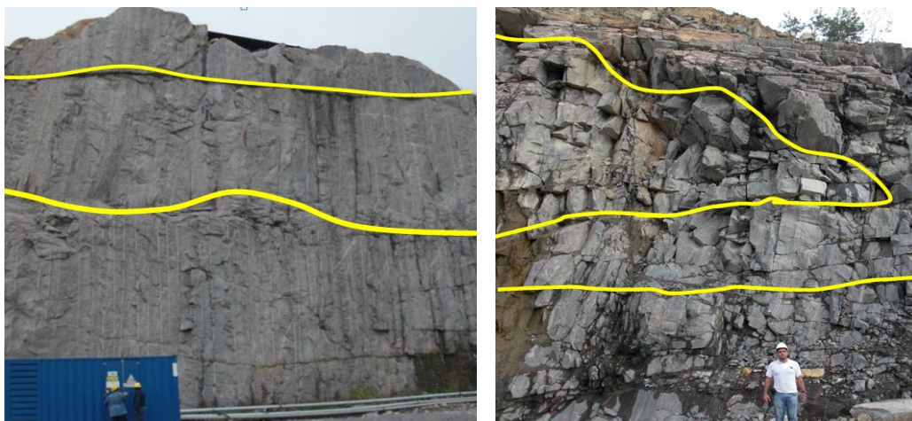
Fotografía 5. Excavación vertical en rocas graníticas al comienzo del canal de descarga de la presa Tocoma, Venezuela. Planos de foliación (en amarillo) a distancias vertical a unos 8 m.
