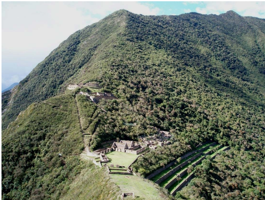
Foto 1. Sitio arqueológico de Choquequirao. Nótese la colina (casi N-S) que separa la ladera oriental (derecha) donde se halla el Chakra andén que estabiliza el deslizamiento D-7; y la ladera occidental (izquierda) mostrando la parte superior del deslizamiento D-8.
