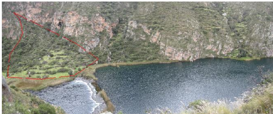
Fig.4 Laguna Huallhua. En esta toma se observa el abanicó deyectivo de la torrentera ubicada en la margen derecha del río Cañete.
