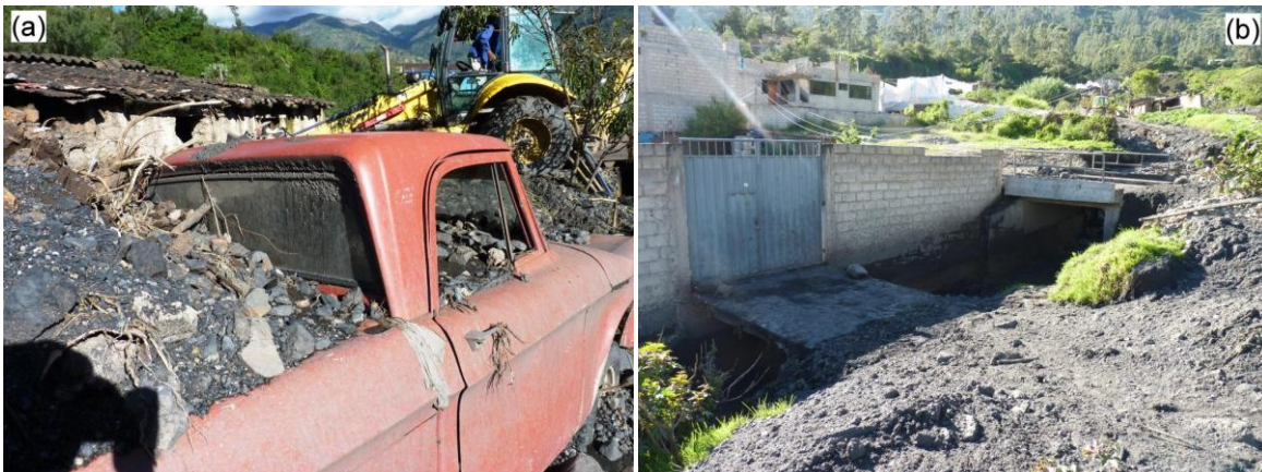
Foto 2a: Vehículo afectado por la crecida de detritos, nótese que si el vehículo está lleno de material del flujo pero los vidrios del mismo están intactos. Foto 2b: Puentes y viviendas que estrechan el cauce de la quebrada Sahuanay.
