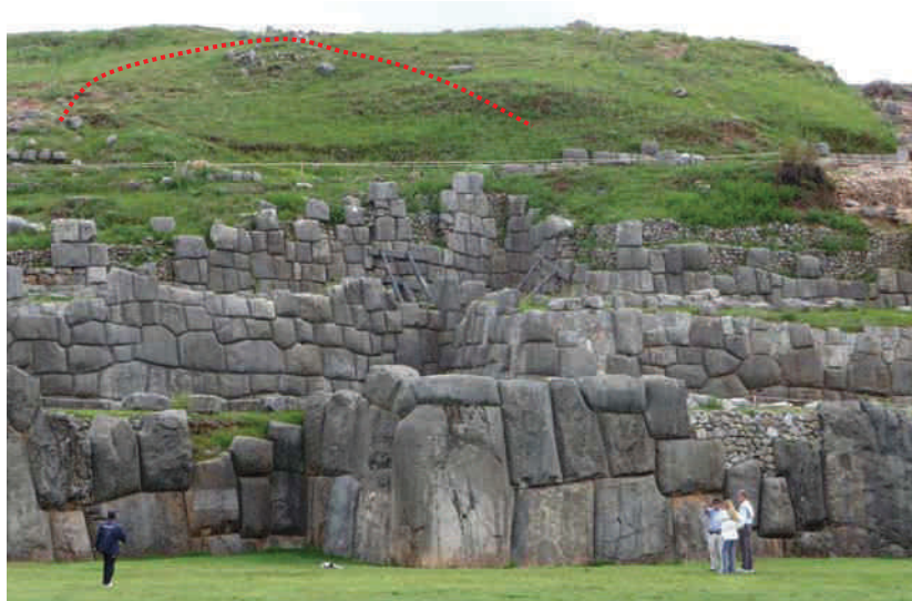
Foto 2. Zona de asentamiento que permite acumulación de las aguas. Abajo muros apuntalados
