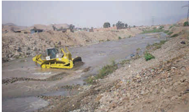
Foto 2. Remoción de material del cauce del río Chillón, en el sector de San Diego, afectado por inundaciones.
