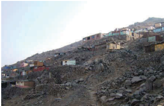
Foto 1 Zona predispuesta a las caídas de rocas de origen antrópico. AAHH Nuevo Amanecer.
