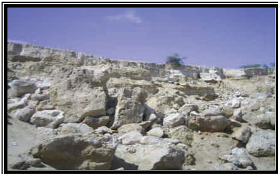
Vista del Deslizamiento San Martín
