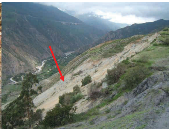
Figura 8. Pendiente fuerte de la ladera; se aprecian afloramientos de agua (puquiales).
