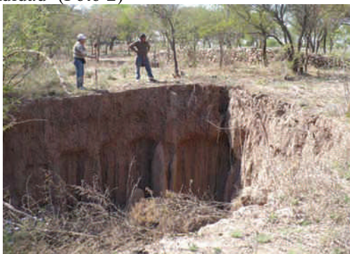
Foto 1 Se observa la cabecera de C1, se puede inferir la profundidad e intensidad del carcavamiento
