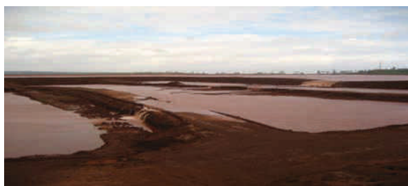
B: Falla de estructuras auxiliares
