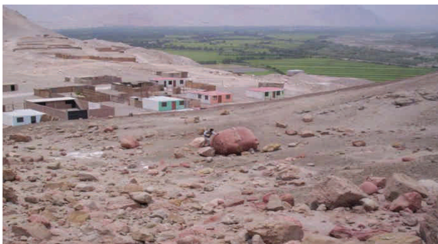
Fotografía 1. En la foto se evidencia el peligro geológico que ocurre en la población de “El Mirador y Altillo”. Desprendimiento de rocas como consecuencia de la actividad sísmica, con una dirección N32°E.
