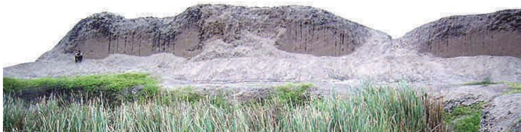
Figura 6. Erosión pluvial en muros de adobe del palacio de Rivero, ciudadela Chan Chan.
