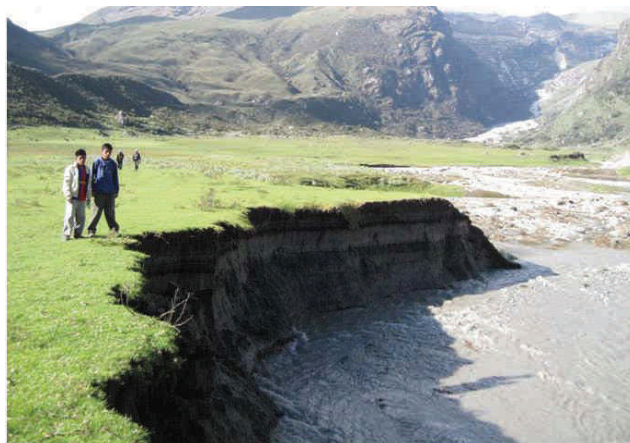
Figura 5: Depósitos lacustres del sector de Shongilpampa. El flujo de detritos erosionó aproximadamente 2 metros en el material, aumentando así su volumen.
