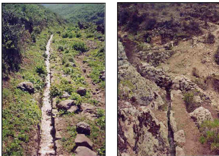
Figura 3. Sistemas de conducción de canales con piedra labrada.
