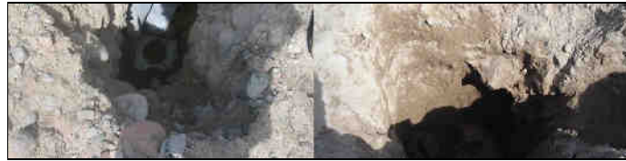
Figura 3 – Ensayo de densidad in situ y apertura de calicatas
