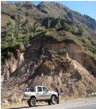
Foto 4. Deslizamiento Rotacional Huaripampa-Matucana
