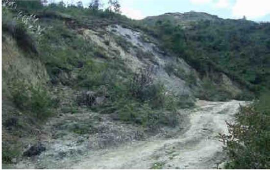
Foto 1. Deslizamiento rotacional que afecta tramo de carretera Santa Rosa de Unanca-Llanavaco.
