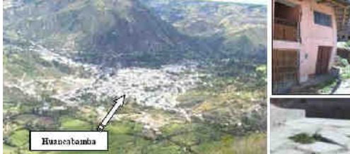
Foto N° 1. Deslizamiento de Huancabamba
