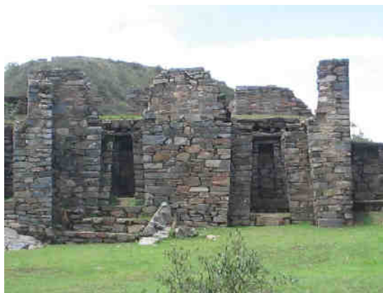
Foto 4: Templo Hurin con separación de juntas en el muro frontal
