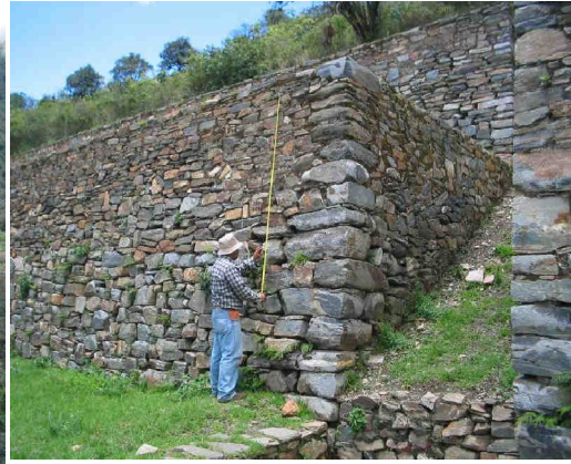
Foto 6: Andenes del Chaqraanden con drenaje de grandes dimensiones
