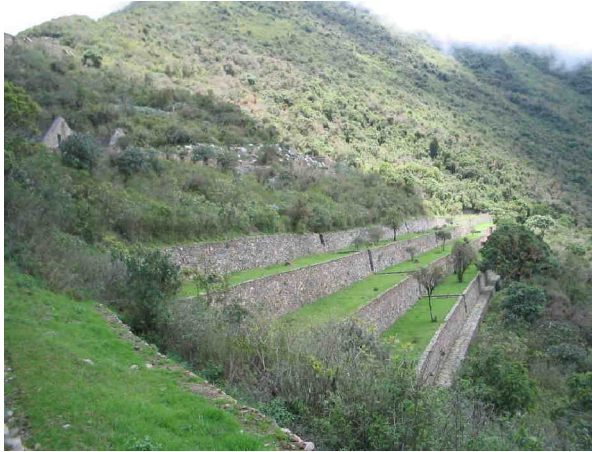
Foto 5: Conjunto de andenes (Chaqraanden) que estabiliza el deslizamiento D-7
