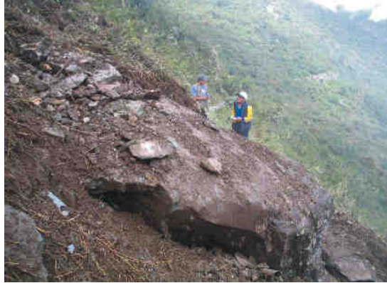
Foto 7. Derrumbe del 2006 que afectó al inca, en camino el tramo Intipunko-ciudad inca.
