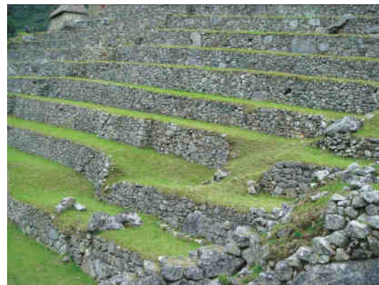
Foto 6. Reptación que afecta a las terrazas agrícolas
