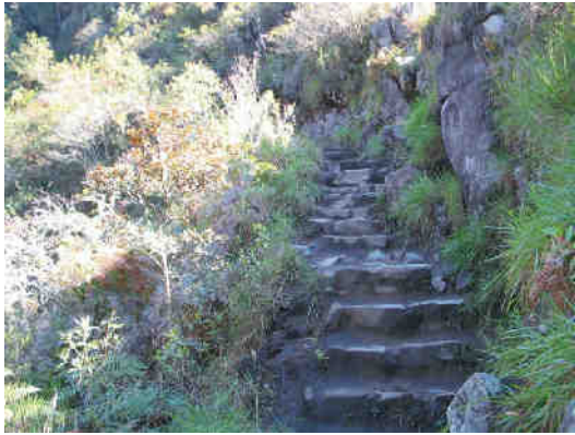
Foto 3. Erosión superficial en el camino inca.
