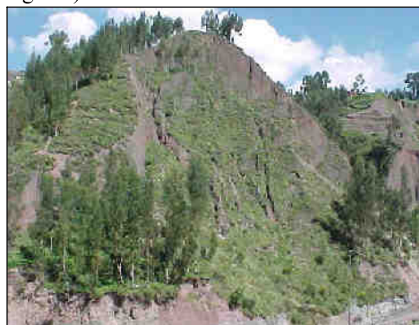
Foto 2. Deslizamiento activo 2A.
