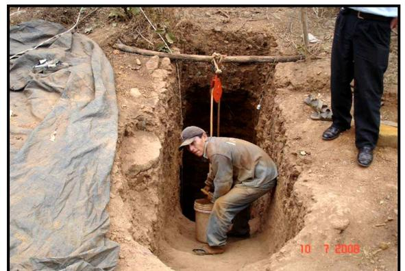
**Foto N° 3:** Pampa Larga - Pique para la extracción de mineral a través de polea y baldes. Minería artesanal en Pampa Larga.
