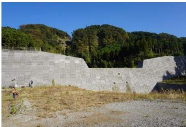
**Foto 4.** Represa SABO para el control de flujos de detritos en Minami-Aso Village (Kumamoto). Nótese el gran tamaño de la misma (Foto: S. Villacorta, 2015).
