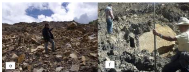
Figura 7. Zona de acumulación del deslizamiento Yanacolpa.
