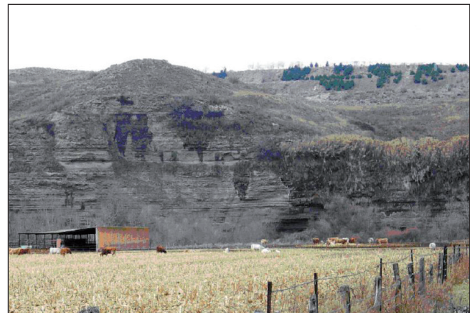
Foto 2. Drenaje a través de fisuras en escarpes yesíferos de la cubeta del Jarama Foto 2. Drainage through fissures in gypsum cliffs in the Jarama basin
