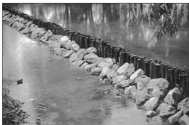
Figura 5.11. Estructura transversal para la retención de sedimentos.
