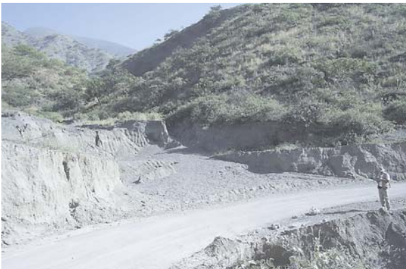
Foto 3. Flujo de lodo de la quebrada San Nicolás.
