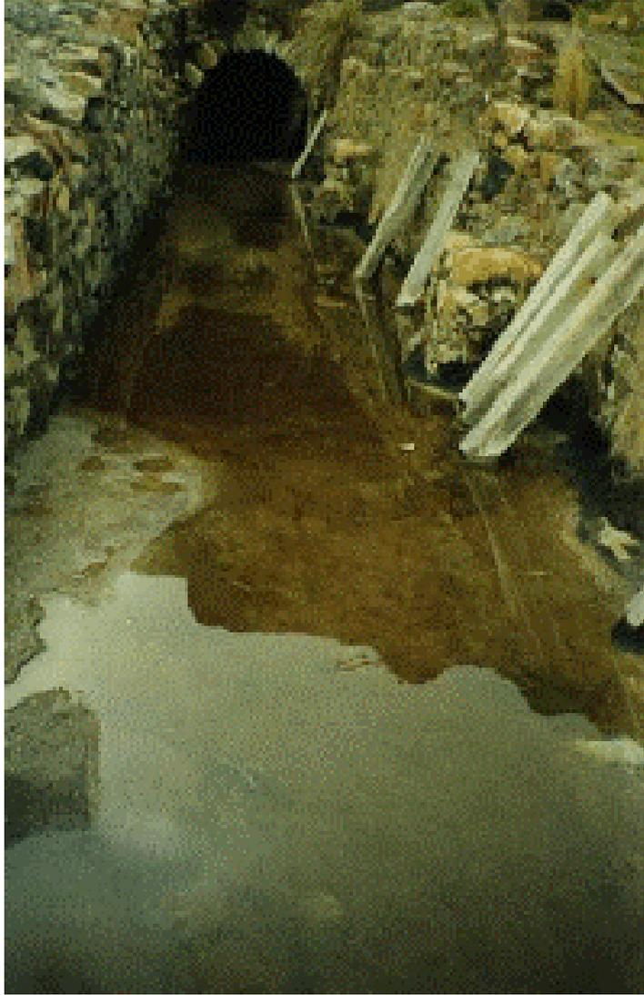
Bocamina principal precariamente estabilizada y con drenaje acido en la mina Perú.
