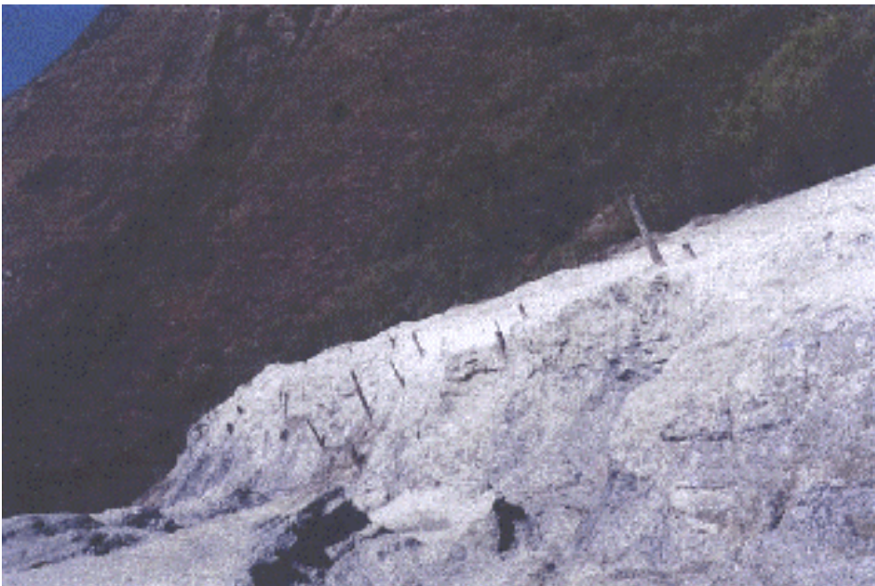
Vista del talud de los relaves de Mina Esparta
