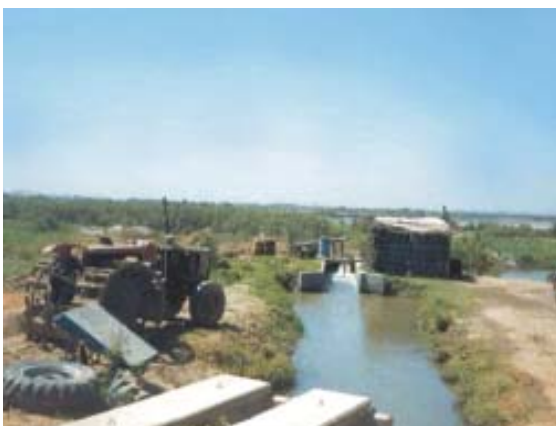
Estación de bombeo para riego, río Chira Sullana - Perú
