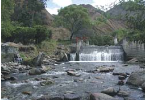
Bocatoma sistema de riego Sanambay - Jimbura, Loja - Ecuador
