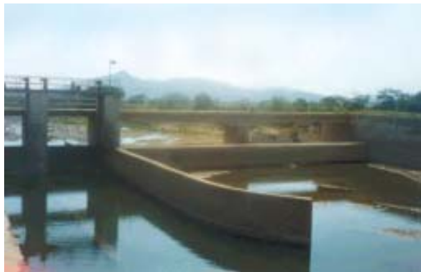
Bocatoma Chipilico, bocatoma y puente. Subcuenca Chipilico, Piura - Perú
