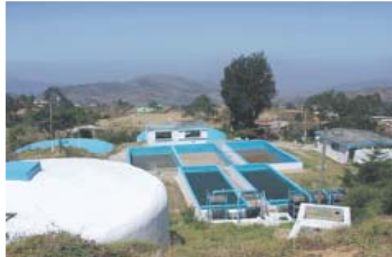
Planta de tratamiento de agua potable Celica - Ecuador
