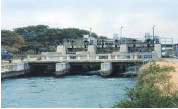
Canal de derivación Daniel Escobar presa Poechos, Piura - Perú
