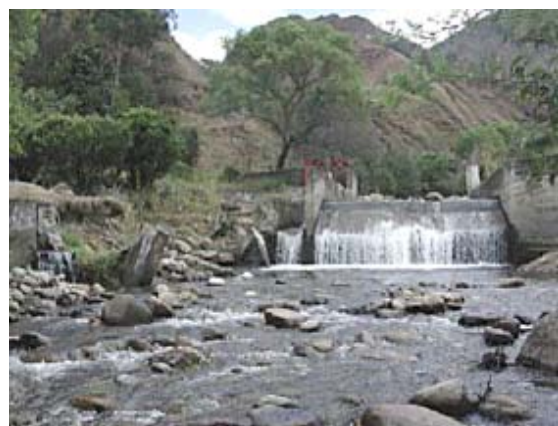
Bocatoma y sistema de riego Quinara Tumianuma, Loja - Ecuador
