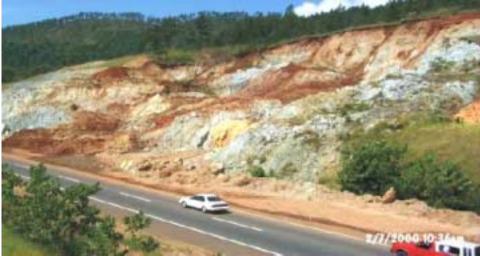
Fig.2 Deslizamientos en suelos de corteza de meteorización en la carretera central de Republica Dominicana. (Rafael Osiris de León 2004)
