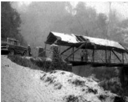
Fig. 28. En regiones más cercanas al centro eruptivo, aparte de la ceniza volcánica, los fragmentos de mayor tamaño pueden producir perforaciones y severos daños a los techos, y a las vías de comunicación. Estas fotos muestran ese tipo de daños producidos por las erupciones del volcán El Chichón en 1982, dentro de un radio de 10 km. Arriba, foto de un techo perforado por líticos. A la derecha un puente semidestruído por impactos de líticos. Fotos de S. De la Cruz.
