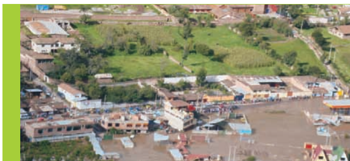
Inundación por desborde del río Urubamba.
