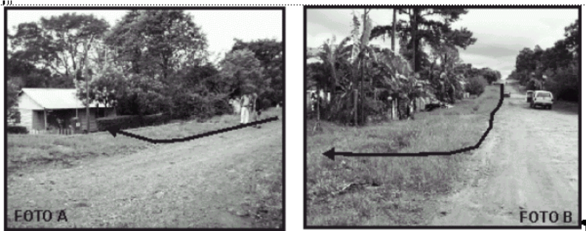
Figura 54. Viviendas afectadas por las inundaciones.
