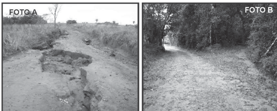
Figura 49. Erosión en caminos en zonas sin selva y construcción de sangrías.
