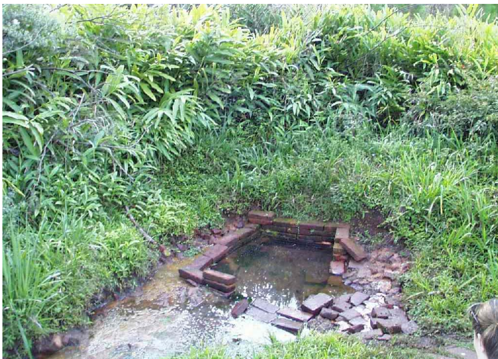
Figura 22. Pozo de la Escuela N° 134, construido en un arroyo.
