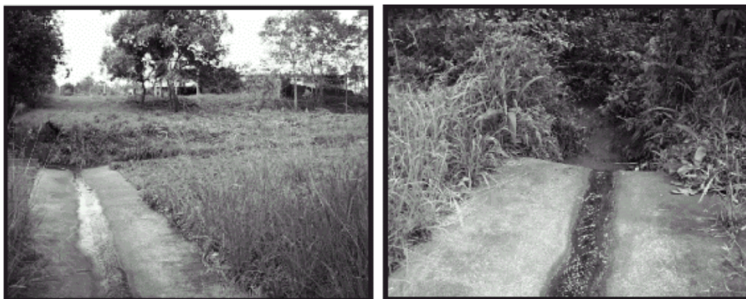
Figura 27. Vertido de efluentes detrás del Hospital.
