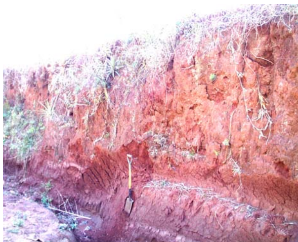
Figura 51. Deslizamiento en taludes de corte de caminos sobreexcavados.
