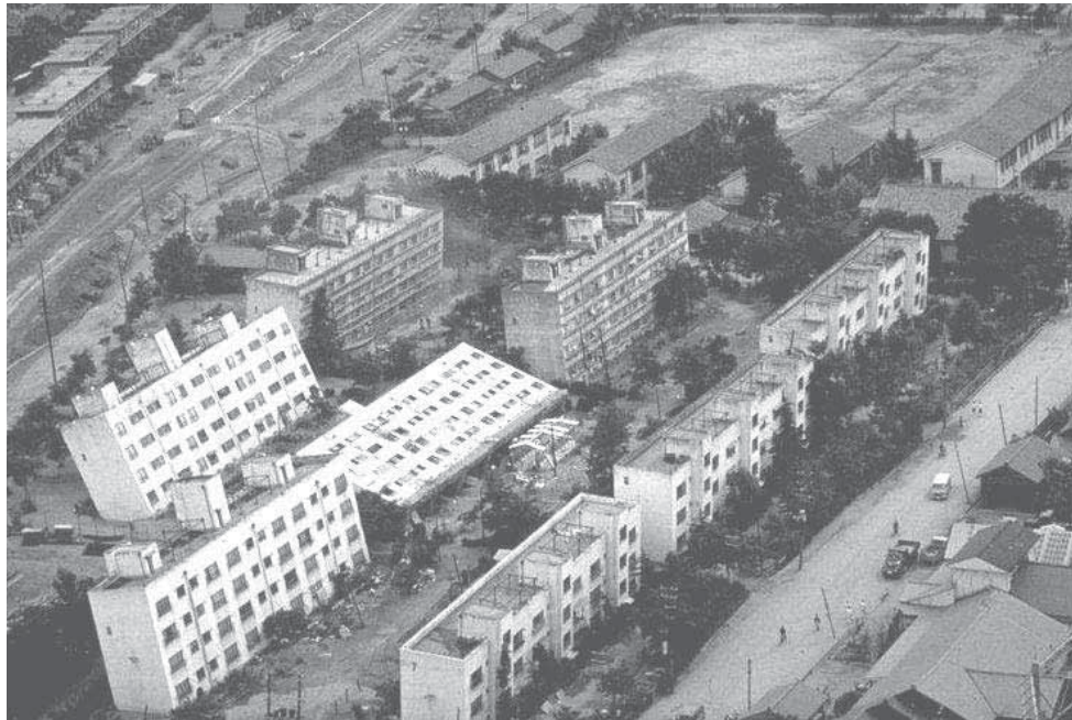
Figura 3.3 Edificios inclinados por licuación de arenas
