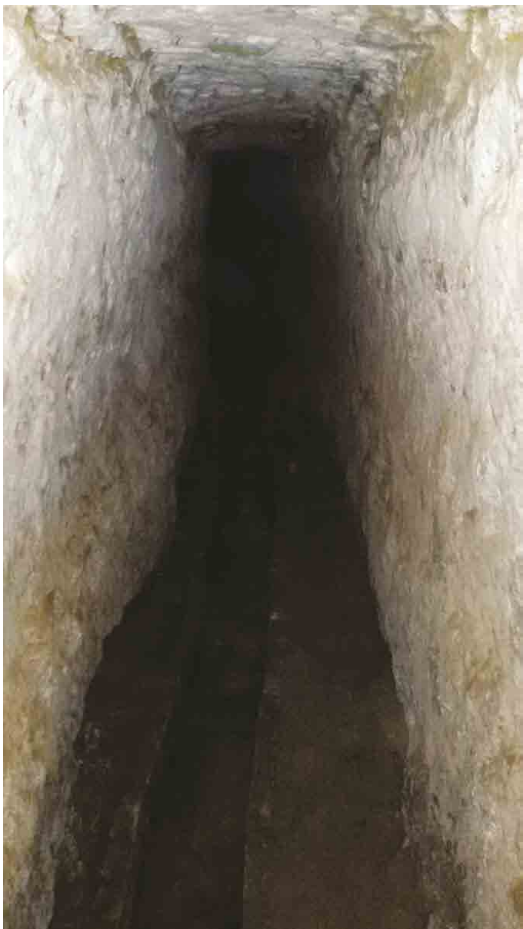
FIG. 3A. Baked clay tiles channel in Comiña socavón.
