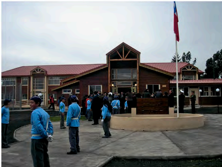
FIG. 32. Vista parcial de la nueva escuela de Las Cascadas.
