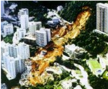
Escorregamento de talude em Hong Kong
