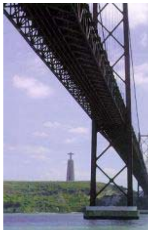
Ponte sobre o Tejo. As fundações das grandes obras de engenharia estão dependentes do substrato em que vão assentar
